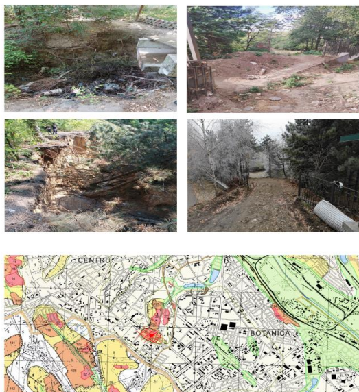
Gestionarea ravenei de pe str. Tudor Strișca 8/1, mun. Chișinău
